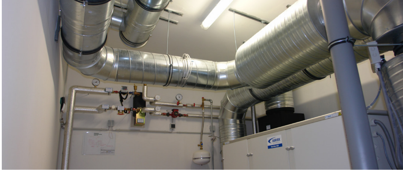
Lüftungszentrale für 15 Wohnungen
