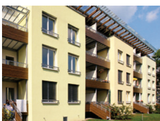
Energetische Modernisierung und Umbau Kollwitzstraße 1-17
