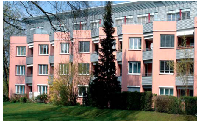
Ansicht von Südwest nach der Sanierung
