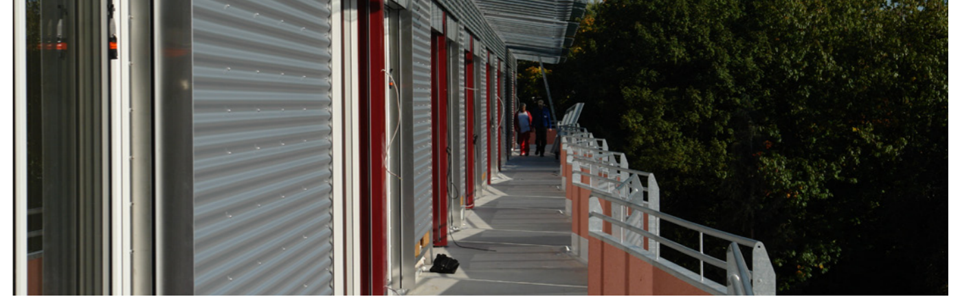
Fertige Dachterrasse vor Anbringen der Trennwände
