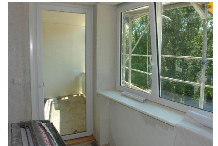
Neue Fenster im Wohnzimmer mit Dreischeibenwärmeschutzverglasung
