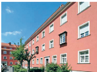
Energetische Modernisierung Wohnanlage St. Johannis, 7-Liter-Standard
