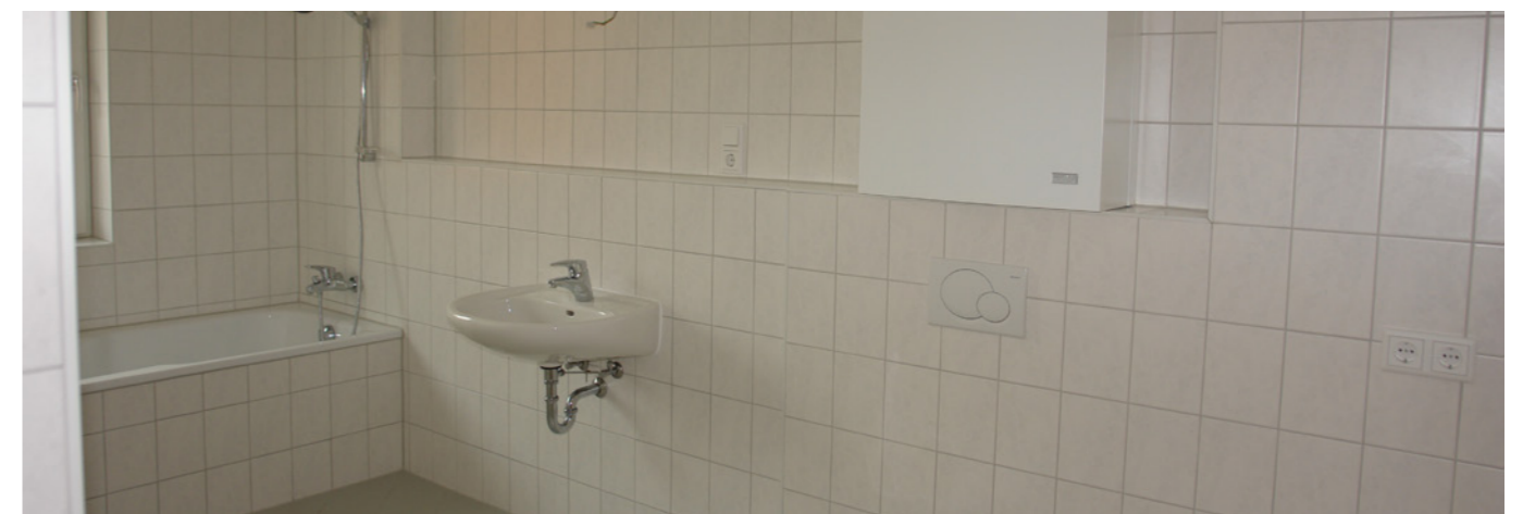
Wärmeübergabe im Bad einer Wohnung mit hohem individuellen Regelungskomfort für die Nutzer
