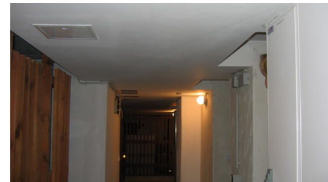
Dämmung der Kellerdecke – die Versorgungsleitungen werden innerhalb der Dämmung im Gangbereich geführt mit der Folge geringerer Leistungsverluste
