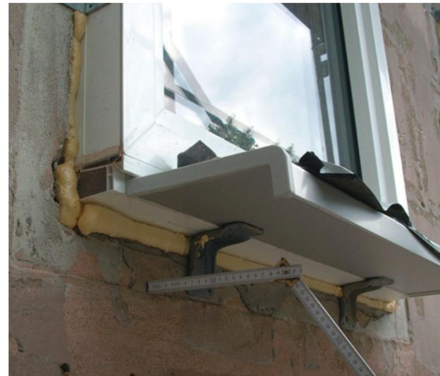
Die Dämmstärke muss von der Fensterbank überbrückt werden und benötigt dafür eine eigene Tragkonstruktion
