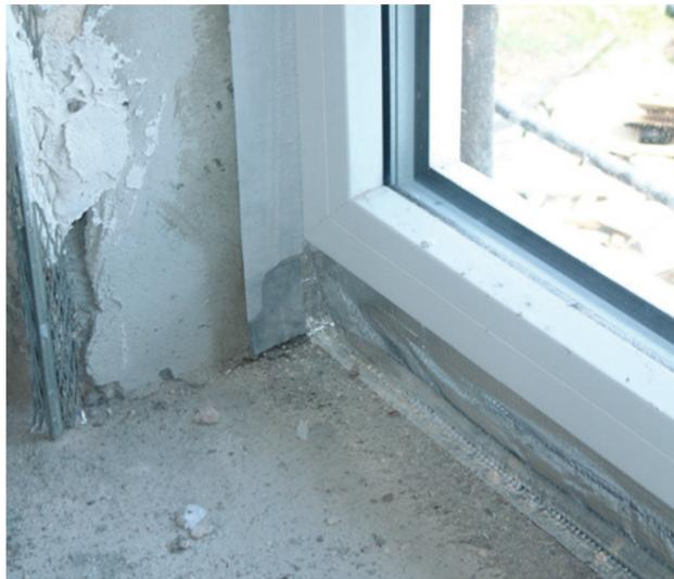
Folienabklebung der Fenster-/wandanschlüsse zur Gewährleistung der Winddichtigkeit
