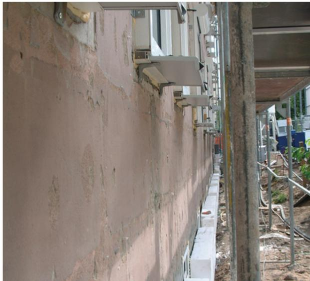
Beim Festereinbau wurde besonders auf die Winddichtigkeit der Fensteranschlüsse geachtet
