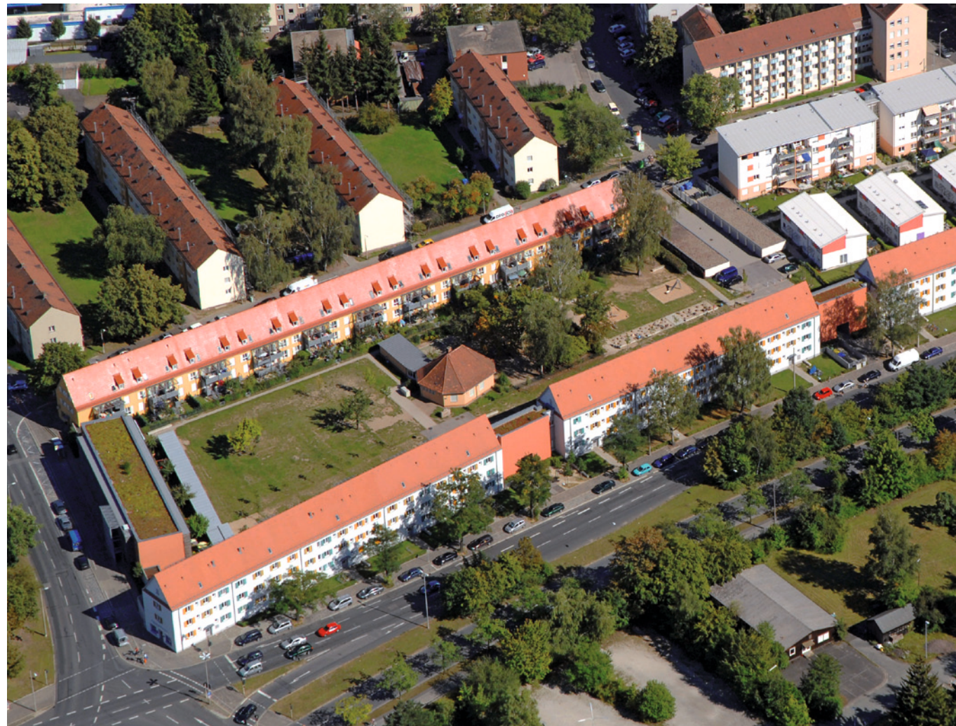
Lärmschutz an der Hansastraße, vorder- und rückseitig betrachtet
