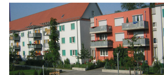
Lärmschutz an der Hansastraße, vorderseitig betrachtet
