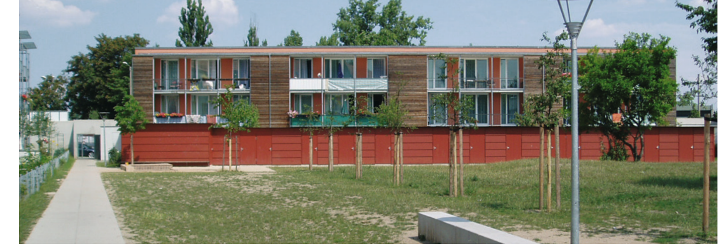
Innenansicht Neubau Gustav-Adolf-Straße
