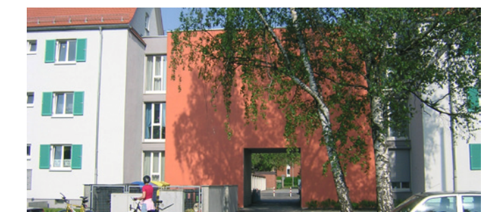
Lärmschutz an der Hansastraße, rückseitig betrachtet
