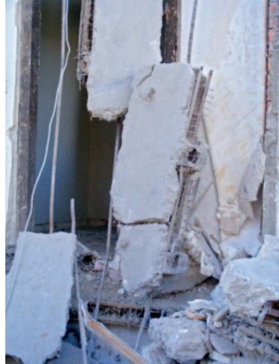
Der Teilabbruch offenbart die zweckentfremdeten Geschosskörbe, die ineinander geschoben wurden und so von einer tragenden Wand zur gegenüberliegenden reichten. Sie sind innen betonfrei, aber mit Beton ummantelt und mit kegelförmigen, metallenen Verschlüssen versehen. Die Konstruktion verbesserte die Statik bei geringerem Verbrauch von wertvollem Beton.
