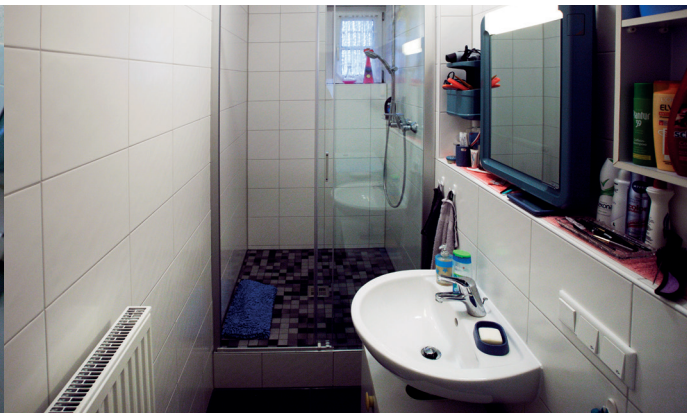
Beispiel Bad nach Umbau
