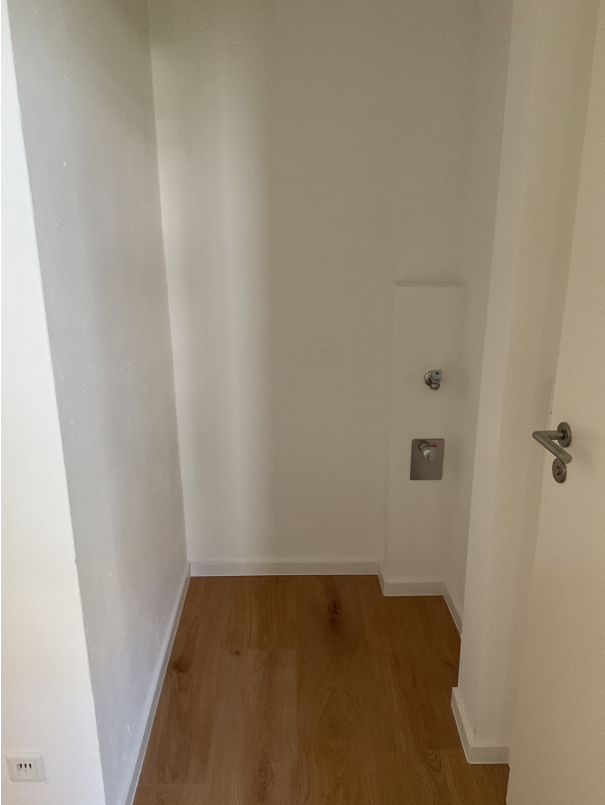
Waschmaschinenanschluss im Flur
