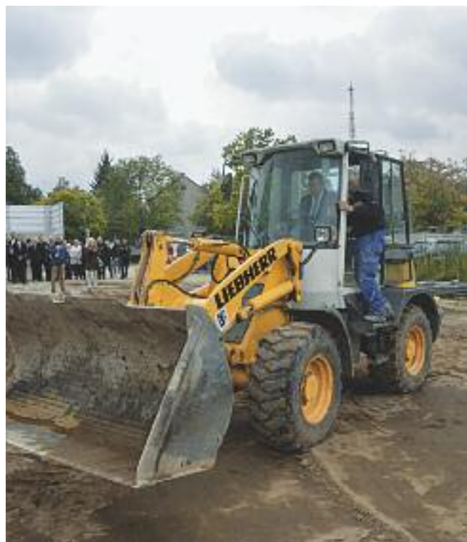
Oberbürgermeister Ulrich Maly lässt sich im Bagger dessen Funktion erklären, um dann den ersten Baggerschub durchzuführen.
