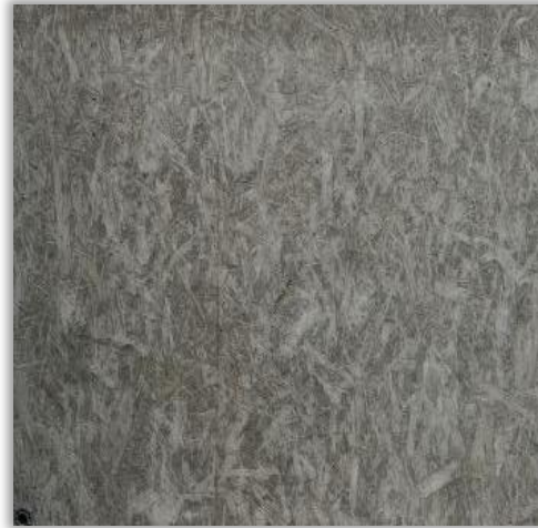
Sichtbeton mit OSB- Schalung
